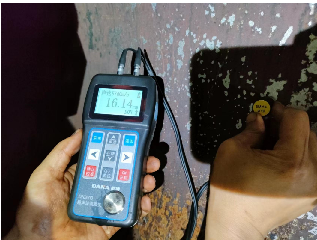
筒体清洗后壁厚检测
