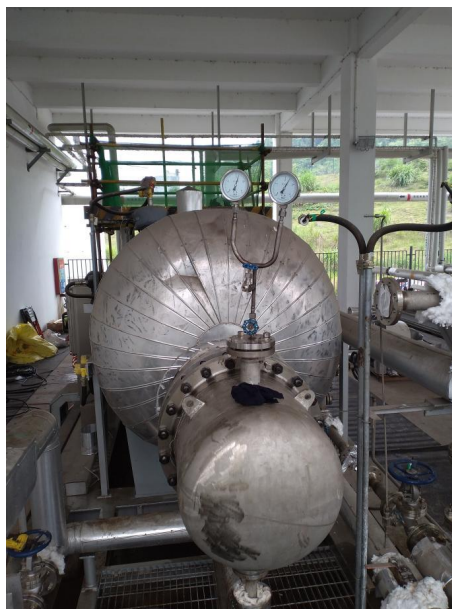
水解器盘管水压试验
